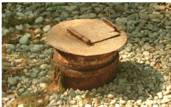
Particolare del tubo in metallo
